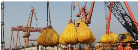
装卸与吊装作业
